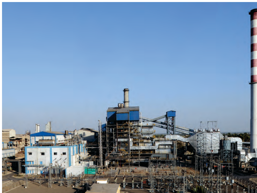
Centralde Energia de 36 MW executada em base EPC para Urjankur Shree Datta SSK Power Co. Ltd., Shirol, (Maharashtra), Índia
