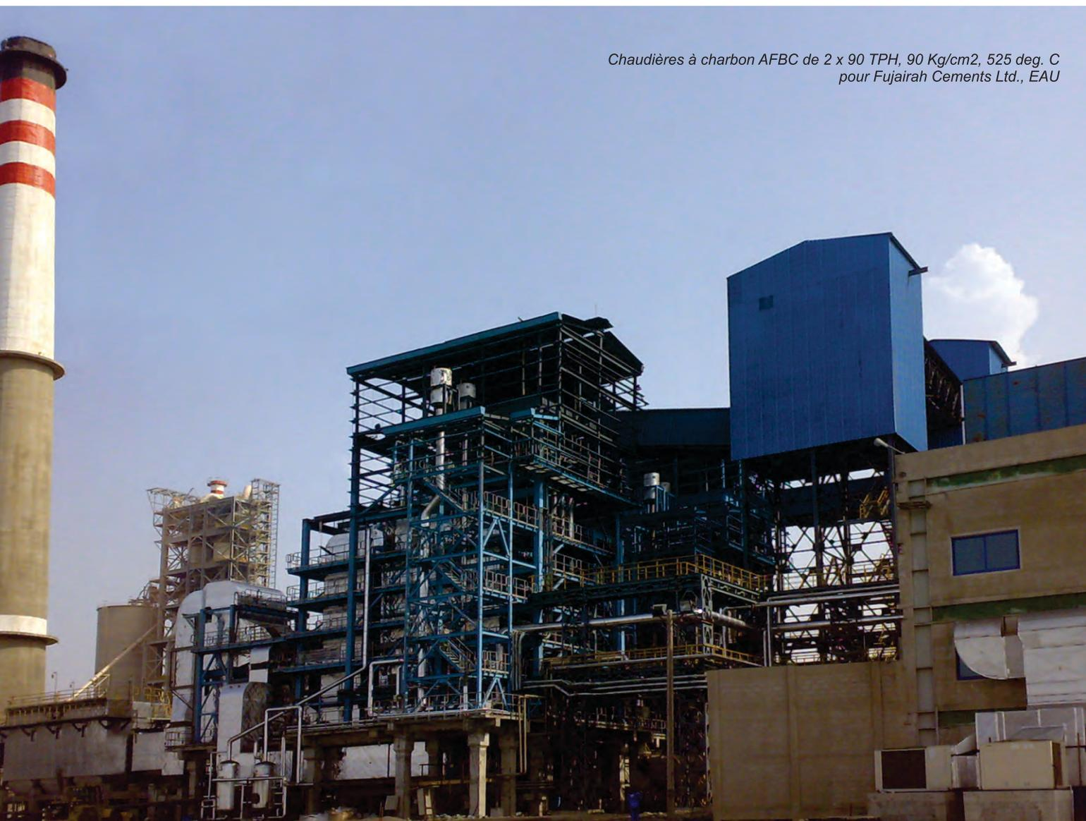
*Chaudières à charbon AFBC de 2 x 90 TPH, 90 Kg/cm<sup>2</sup>, 525 deg. C pour Fujairah Cements Ltd., EAU*
